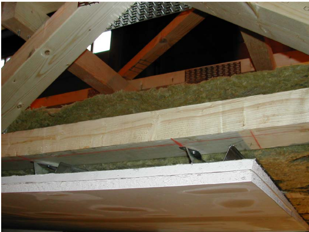
Foto 3 Bjelkelaget sett fra siden.
