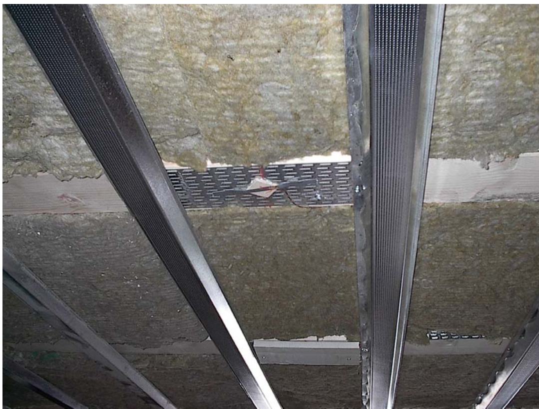
Foto 2 Deler av bjelkelaget er montert, her spikerplater, isolasjon og lydbøyer.
