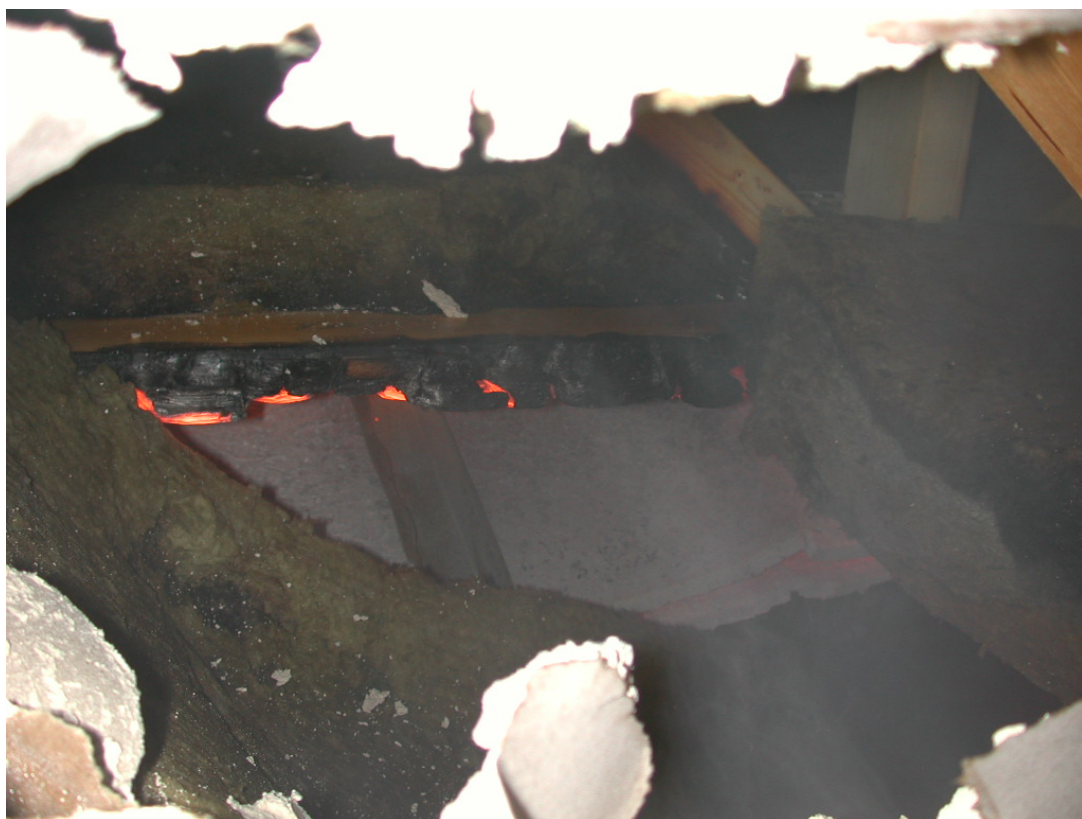
Foto 7 Sett fra siden, 3 minutter etter avsluttet test. Det er tatt hull i siden etter test.
