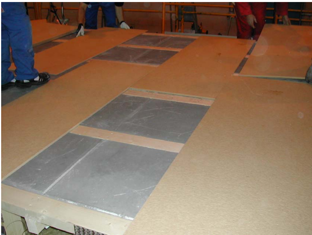
Foto 4 Oversiden av bjelkelaget under oppbyggingen.
