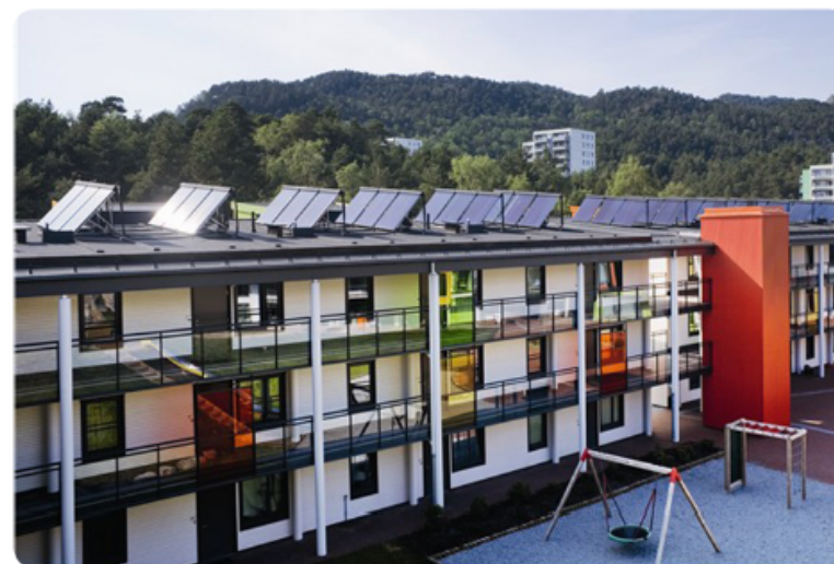
Lavblokker på Løvåshagen i Bergen. Arkitekt: ABO arkitekter
