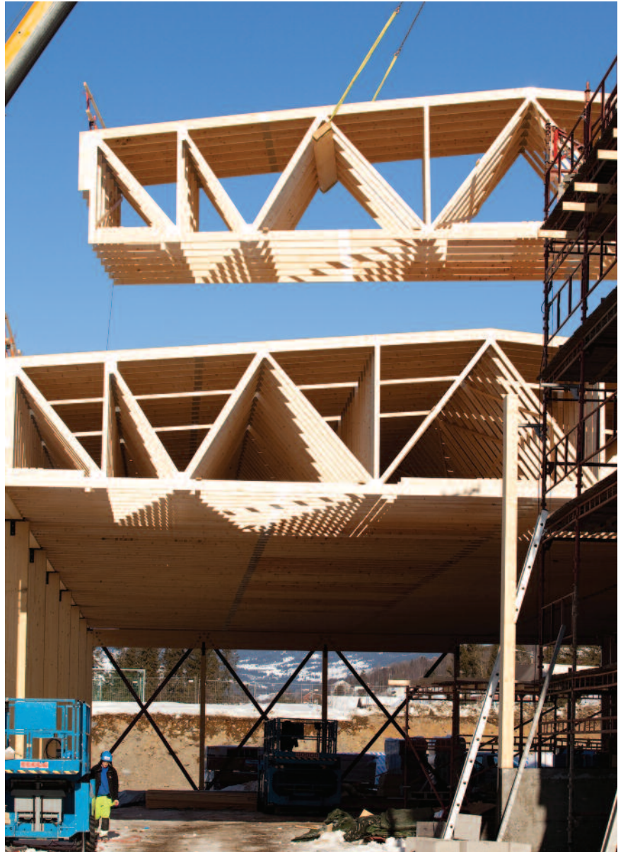
Montering av tak på industribygg. Takelementet bygges på bakken, og heises på plass. Hvert element er 120 m 2 , og på en dag ble det montert 680 m 2 tak. Totalt er bygget 5.200 m 2 . (Pretre AS)
