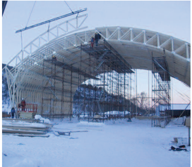
Montering av idrettshall. (Multikon AS)
