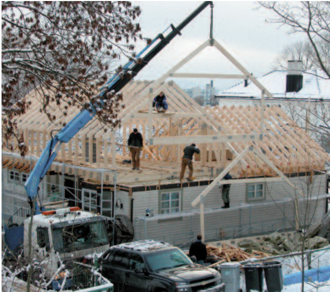
Påbygging av ny etasje. (Treteknisk)
