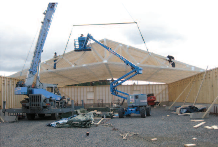
Montering av saksetakstoler. (Mjøstre AS)
