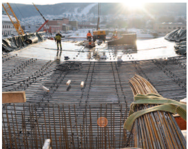
Forskaling til Øvre Sundet bru i Drammen. (Treteknikk AS)
