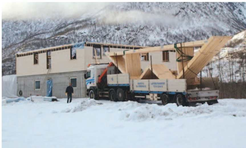
Takstoler på byggeplass klare for montering. (Mjøstre AS)
