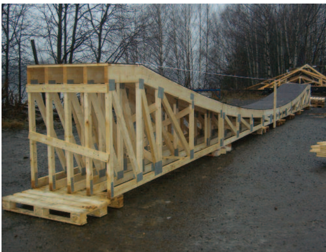
Element av forskaling Øvre Sundet bru montert på bakken. (Treteknikk AS)
