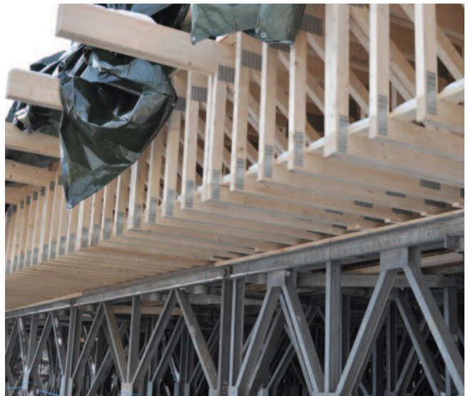
Forskaling til Øvre Sundet bru i Drammen. (Treteknikk AS)
