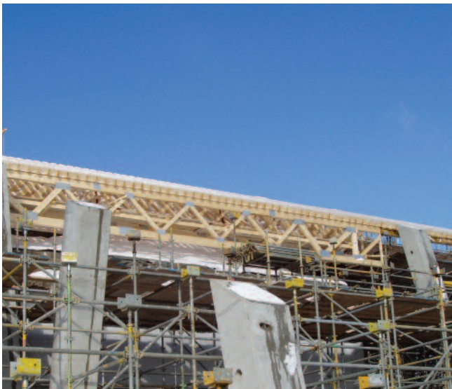
Gitterdragere brukt i forskaling ved nye Holmenkollen. (Takstolteknikk AS)
