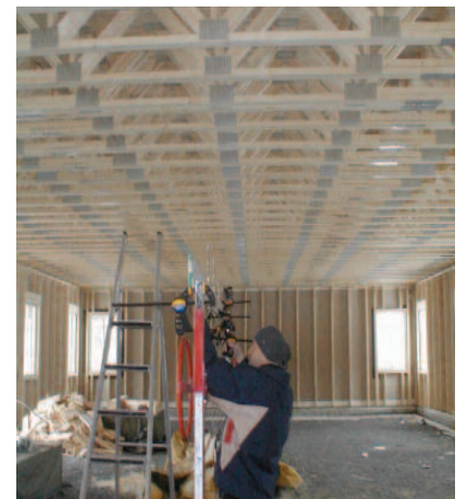
Gitterbjelker brukt som frittstående bjelkelag. (NTF)
