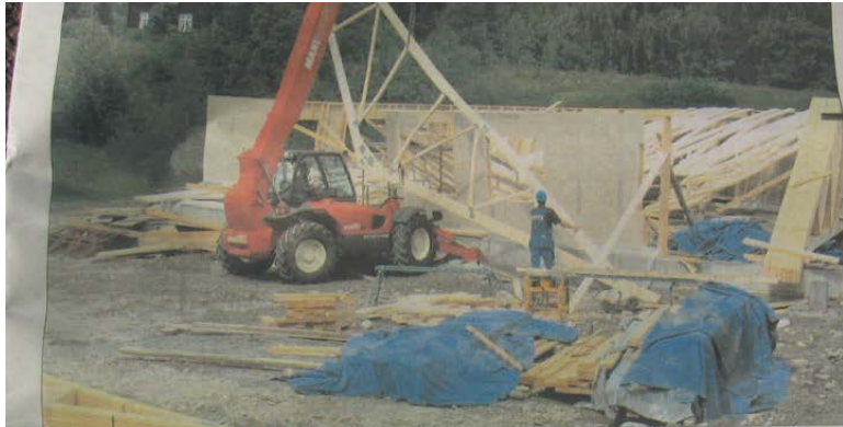
OPPRYDDING: Det var full opprydding på byggetomta etter uhellet i går ettermiddag.
