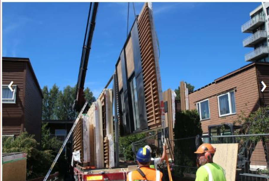
De største fasadeelementene veier 1,5 tonn.
