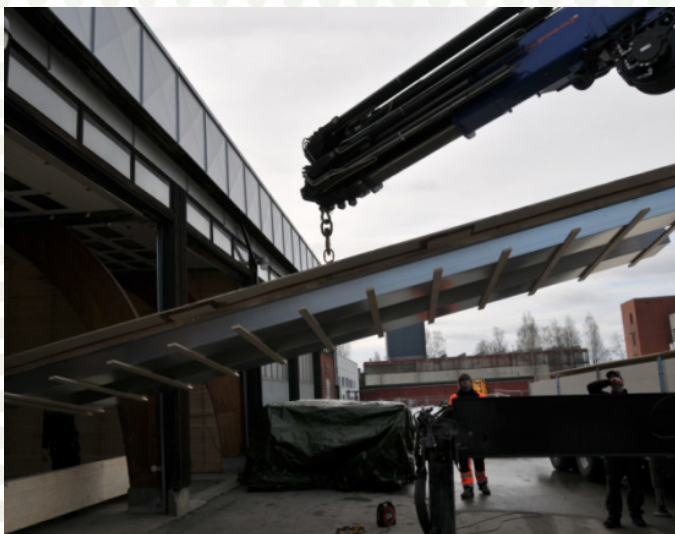
Elementer løftes inn i lab'en
