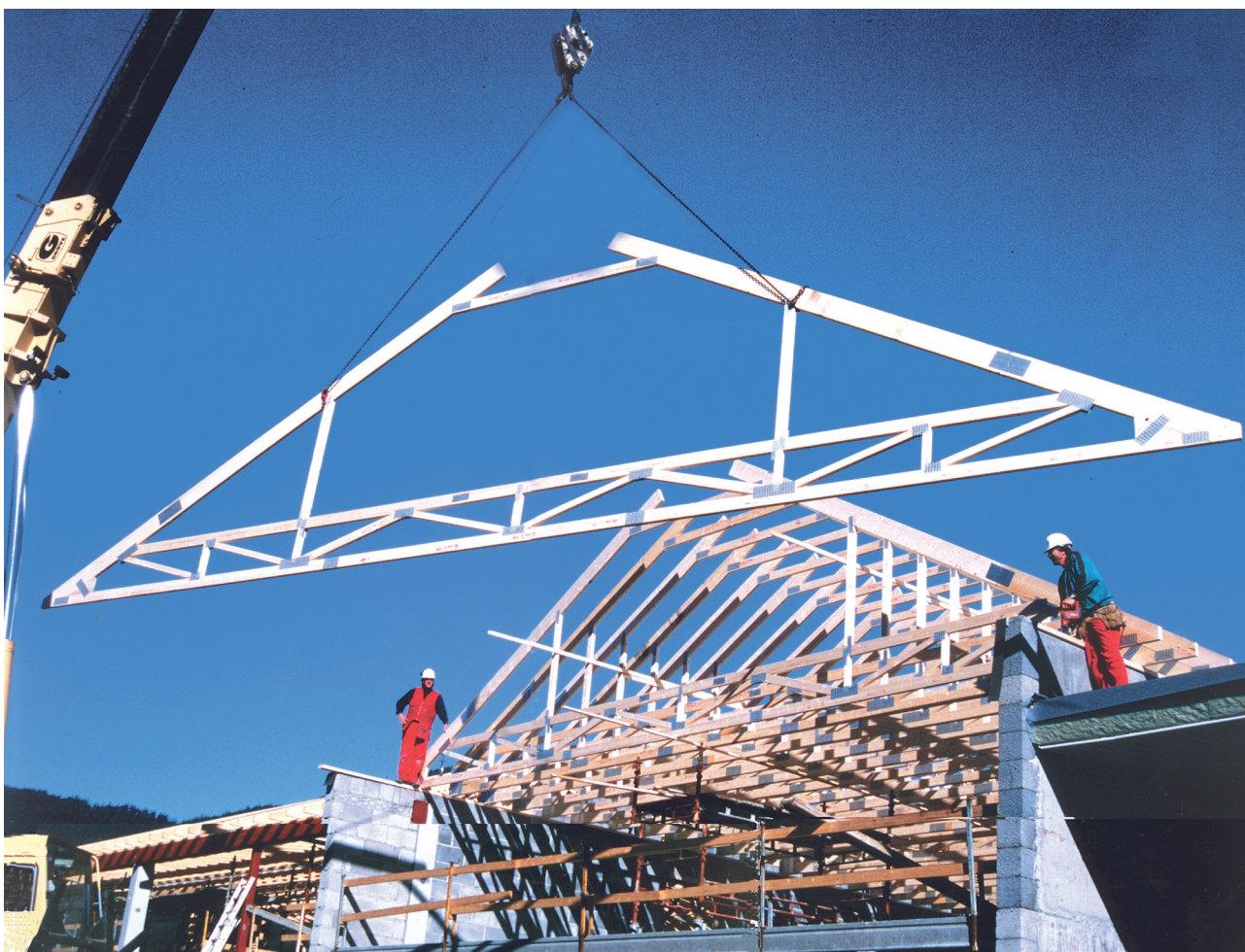
Figur 1.1 Konstruksjoner under montering. Leverandør: Kaupanger Tre AS.
