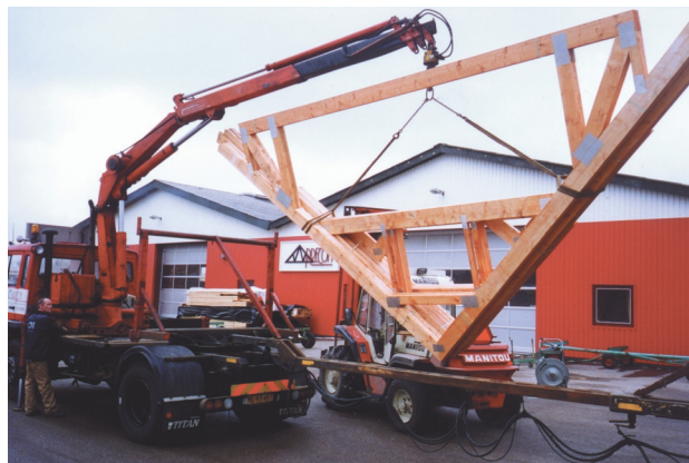
Figur 10.11 Stroppingen ved snuing av takstoler må gjøres riktig.
