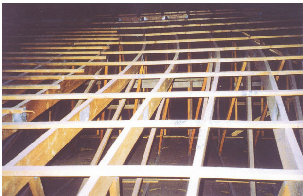
Figur 11.1 Dersom ikke avstivningene utføres forsvarlig, kan dette skje. Her er ikke lektene forankret til stive områder i takflaten, og alle overgurtene har knekt ut samme vei.
