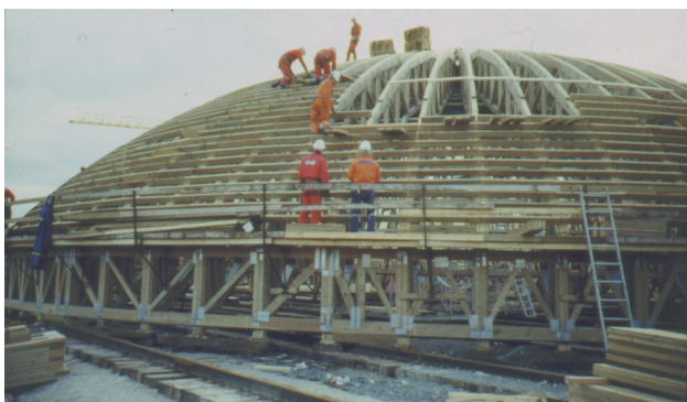
Figur 2.9 Forskaling til Trollplattformen, buede gitterdragere (kilde: NTI).
