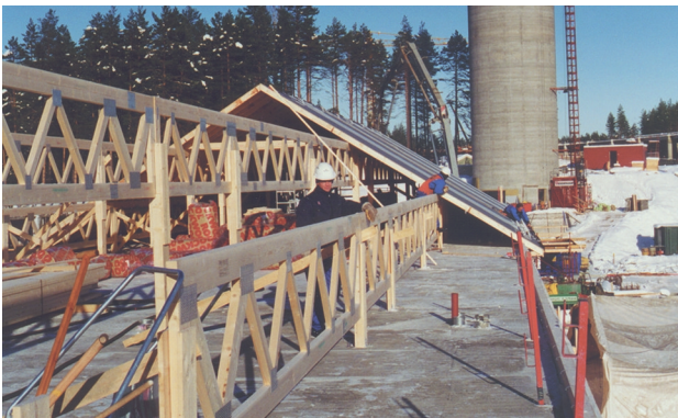
Figur 2.7.3 Fra Rena Leir. Gitterdragere og takelementer. Leverandør: RingAlm Tre AS.
