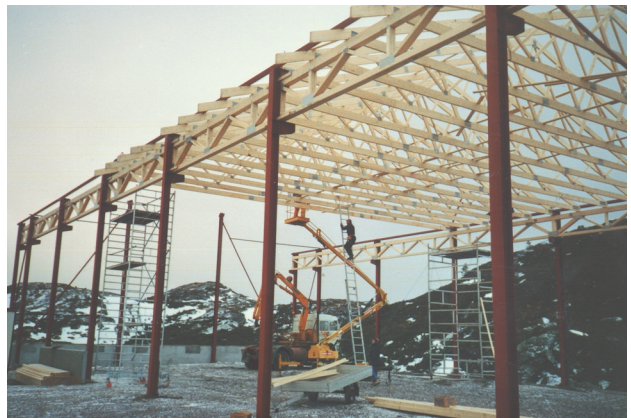
Figur 2.11.6 Industribygg. Leverandør: Vest Tre AS.
