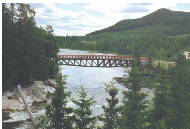
Figur 2.10 Fossbroen i Atna, 21 gitterdragere i hver hoveddrager. Leverandør: Trekonstruksjoner AS.
