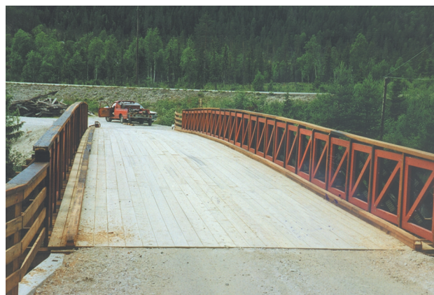
Figur 2.10 Fossbroen i Atna, 21 gitterdragere i hver hoveddrager. Leverandør: Trekonstruksjoner AS.
