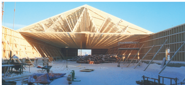
Figur 2.11.9 Landbruksbygg. Leverandør: Takstolfabrikken AS.
