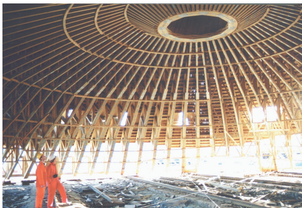
Figur 2.9a Samme konstruksjon sett innenfra (kilde: NTI).
