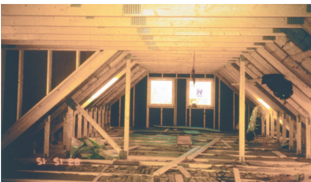
Figur 4.8 Påbygg av en loftetasje kan gjøres rasjonelt med takstoler (kilde: NTF).
