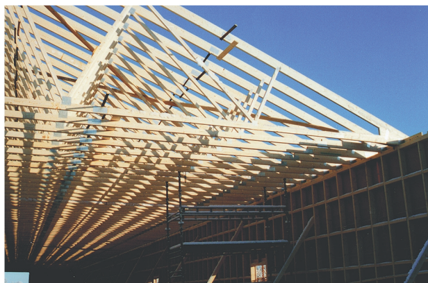
Figur 4.2 Takstolen er mye brukt både i boliger, institusjonsbygg, lagerbygg og landbruksbygg (kilde: Takstoffabrikken A/S).
