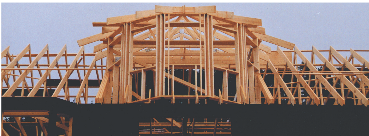
Figur 4.16.2 Spikerplatekonstruksjoner egner seg godt til forskalinger. Bildet til venstre viser eksempel på en bro-forskaling. Leverandør: Kaupanger Tre AS.
