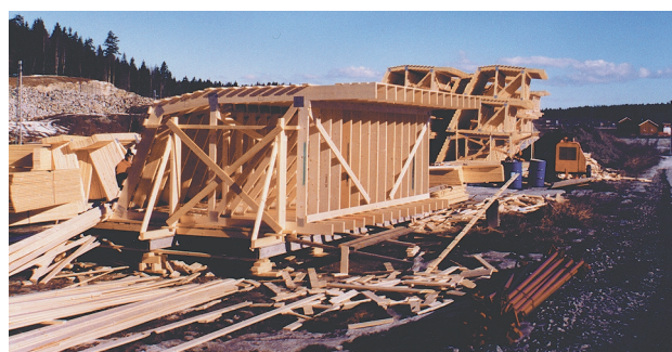
Figur 4.12 Forskaling til radartårn på Gardermoen. Alt ble montert sammen nede på bakken og heist opp på tårnet i bakgrunnen (kilde: Takstolfabrikken AS).
