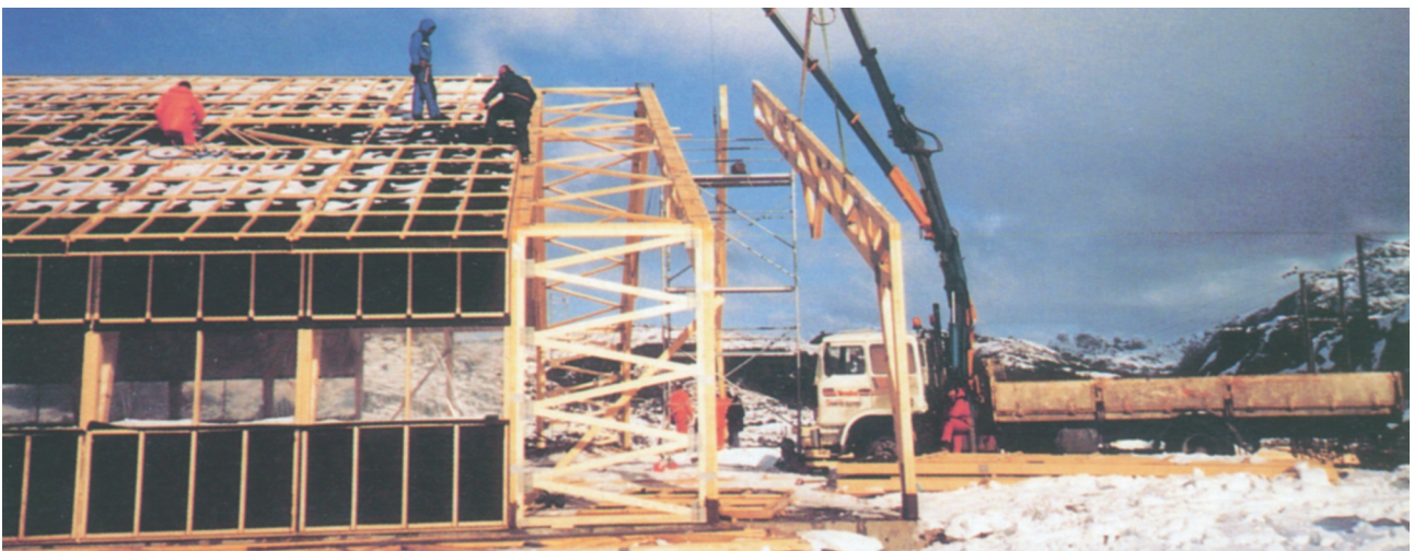
Figur 4.15 Avstivningsfagverk i industrihall. Monteres inn mellom rammer i enden av hallen (kilde: Vest Tre AS).
