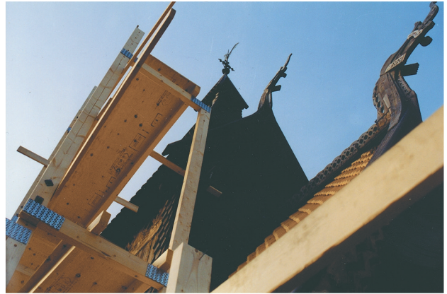
Figur 4.16.4 Stillas for restaurering av en stavkirke. Leverandør: Kaupanger Tre AS.
