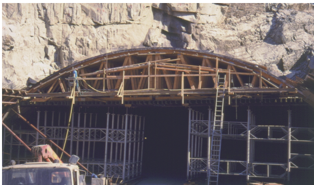
Figur 4.11 Forskaling til biloppstillingsplass – Mannheller. Leverandør: Kaupanger Tre AS.
