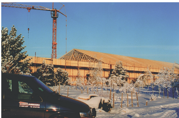
Figur 4.2 Takstolen er mye brukt både i boliger, institusjonsbygg, lagerbygg og landbruksbygg (kilde: Takstoffabrikken A/S).
