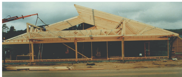
Figur 4.4 Gitterdragere som opplegg for pulttakstoler med forlenget overgurt. Det skal monteres limtreddrager i mønet. Det er også gitterdragere i bjelkelaget (kilde: Nordisk Kartro AS).
