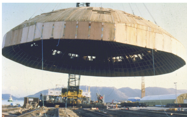
Figur 4.13 Fra arbeidet med Trollplattformen – et gjen-nombrudd for brukerne av fagverkbuer i kompliserte forskalinger av stort format (kilde: NTI).
