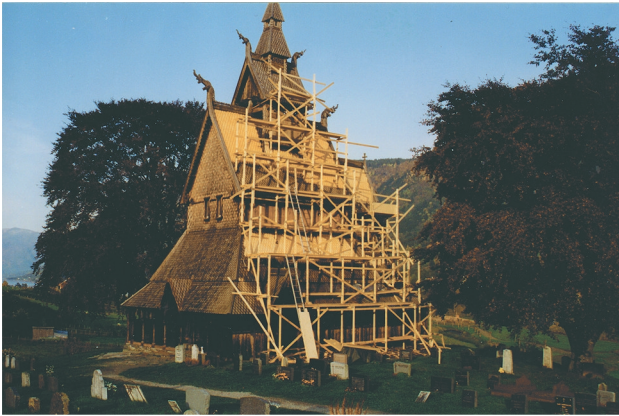
Figur 4.16.4 Stillas for restaurering av en stavkirke. Leverandør: Kaupanger Tre AS.
