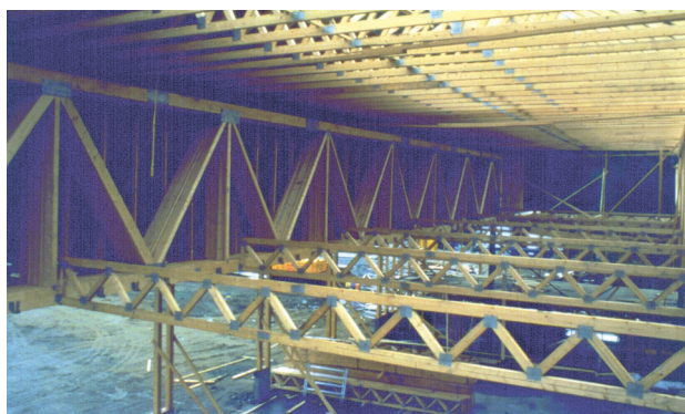
Figur 7.3 Eksempel 2: Hver drager består av 10 stk. gitterdragere med høyde 3 m. Leverandør: Naglestad Bruk AS.
