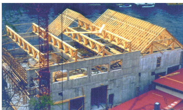
Figur 7.2 Eksempel 1: I den ferdig monterte seksjonen er bjelkelaget dimensjonert for bruk til kontor og velferdssrom. Leverandør: Naglestad Bruk AS.
