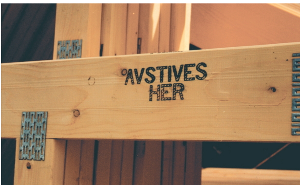
Figur 9.21 Stempel som viser at det på byggeplassen skal monteres sideveis avstivning.
