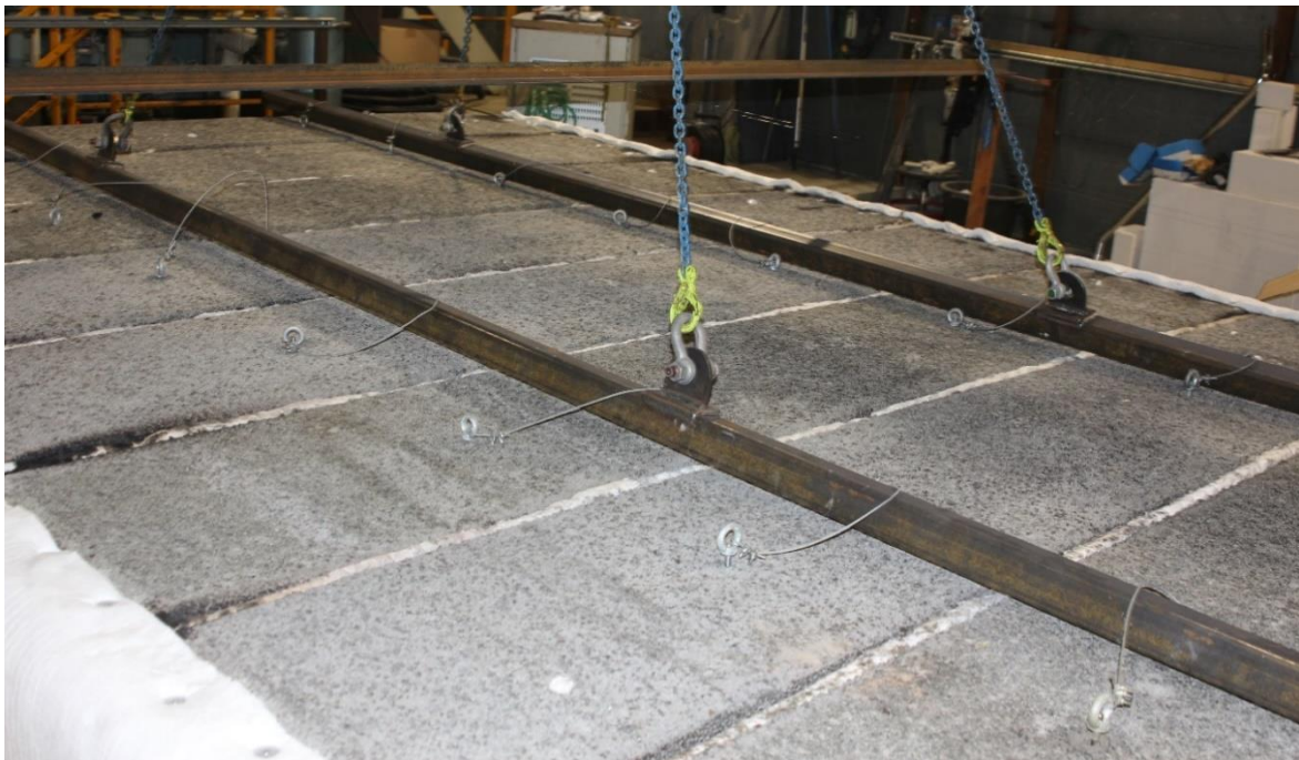
Figur 7 Leca Byggeplank ble løftet og lagt ned på teglsteinene på takstolene med AES-fiberisolasjon mellom hver Leca Byggeplank. Hempene er laget av stålvaier og Leca anker, og ble brukt til å løfte av/på.
