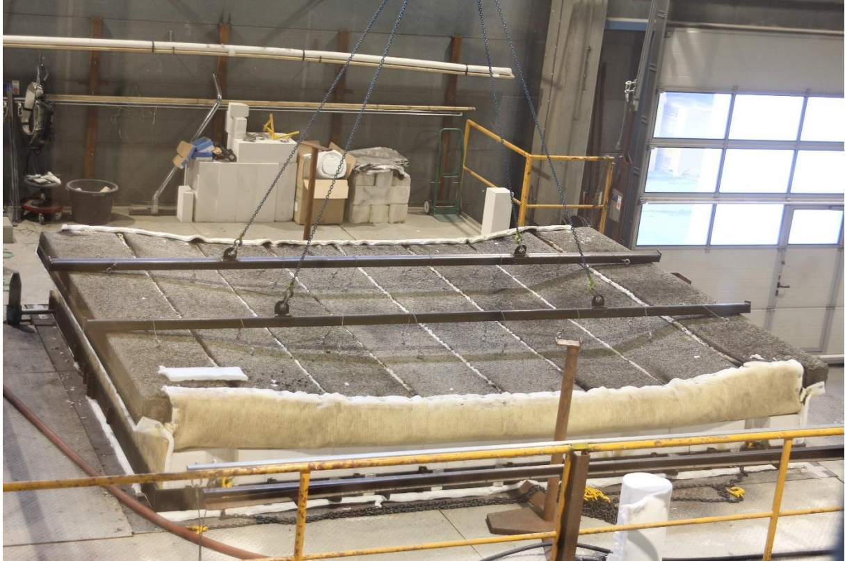
Figure 8 Ueksponert side av Leca Byggeplank etter kollaps av takstolene.
